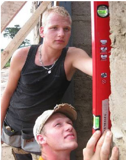
Stefan en Mitch controleren of een muur te lood staat
