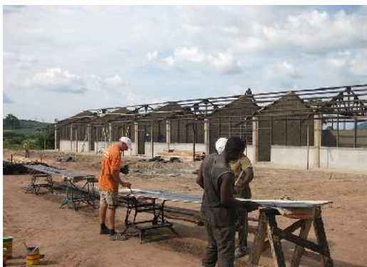
Stefan wordt verrast want de dakspanten staan al
